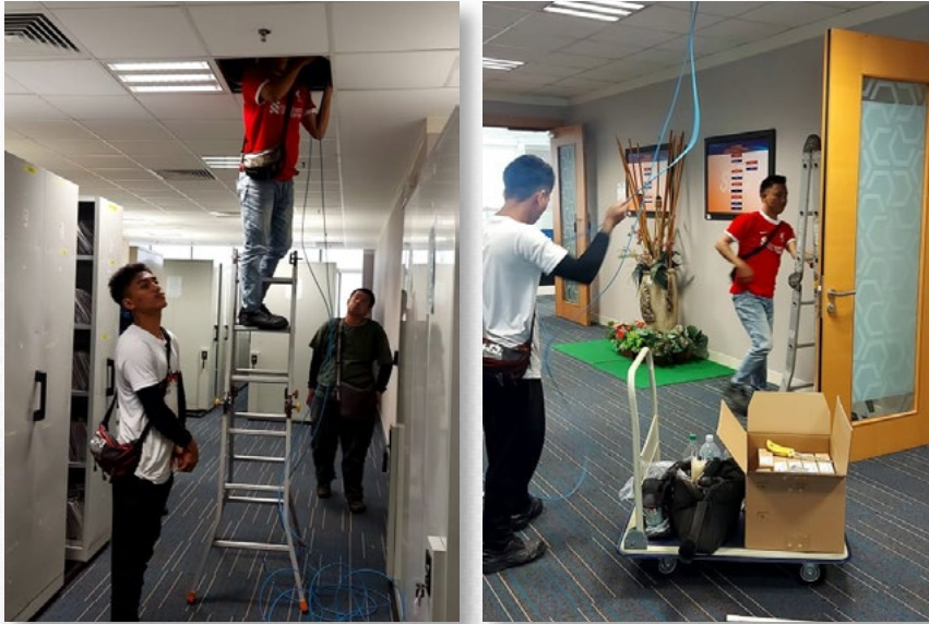
Proses Pemasangan Access Point
